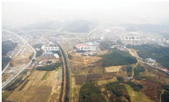
岗公岭-老虎岭-周家畈坝体现状(北向南拍摄)
