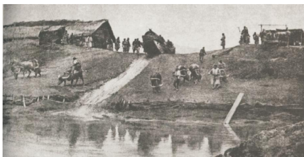
牛拉船只过坝照片(20世纪初杭州地区)
