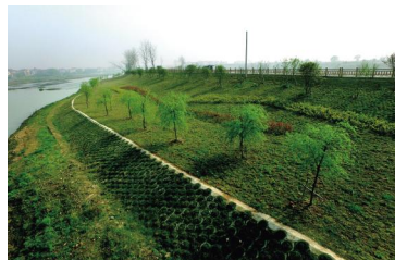
江山港生态防洪堤
